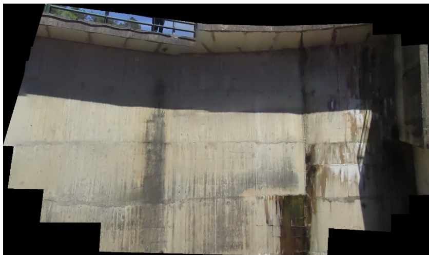
Figura 7 – Ortomosaico obtido com imagens captadas pela aeronave em ambiente operacional na barragem de Fagilde
